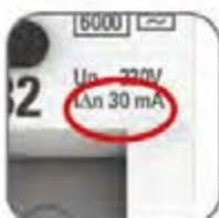
**Номинальный отключающий дифференциальный ток  $I_{\Delta n}$**  – это значение отключающего дифференциального тока, при котором УЗО должно срабатывать при заданных условиях.
