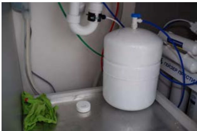
Рисунок 4 – Варианты установки датчика протечки
