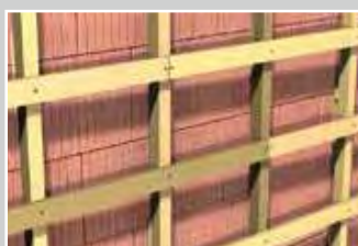
Fassadenunterkonstruktion
