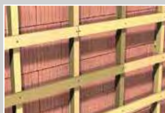
Fassadenunterkonstruktion
