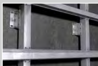
Fassadenunterkonstruktion
