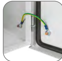
Обмедненные шпильки. Закрепленный поводок заземления
