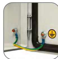
Обмедненные шпильки заземления. Закрепленный поводок заземления
