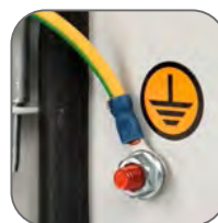
Обмедненные шпильки. Закрепленный поводок заземления
