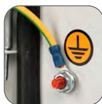
Обмедненные шпильки. Закрепленный поводок заземления
