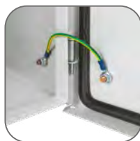
Обмедненные шпильки. Закрепленный поводок заземления
