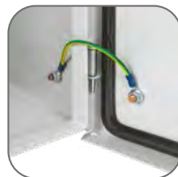
Обмедненные шпильки. Закрепленный поводок заземления
