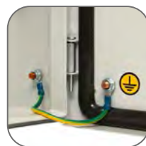
Обмедненные шпильки заземления. Закрепленный поводок заземления
