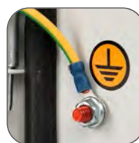
Обмедненные шпильки. Закрепленный поводок заземления
