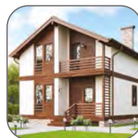
Защита частных домов и сооружений
