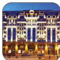
Защита высотных домов и гостиничных комплексов
