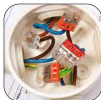
Для организации разводки внутри распределительных коробок применяются безвинтовые и винтовые клеммники
