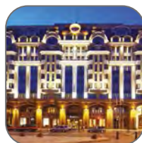
Защита высотных домов и гостиничных комплексов
