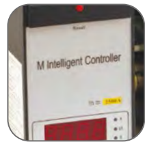
Микропроцессорный расцепитель с селективной программируемой защитой
