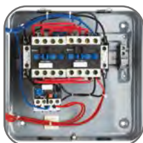
Реверсивная схема исполнения
