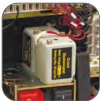
Катушки включения/отключения в базовой комплектации
