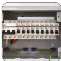
Коммутация групповых аппаратов выполнена трехрядной соединительной шиной
