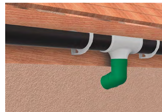
Рис. 40 Установка колена на сливное отверстие воронки
