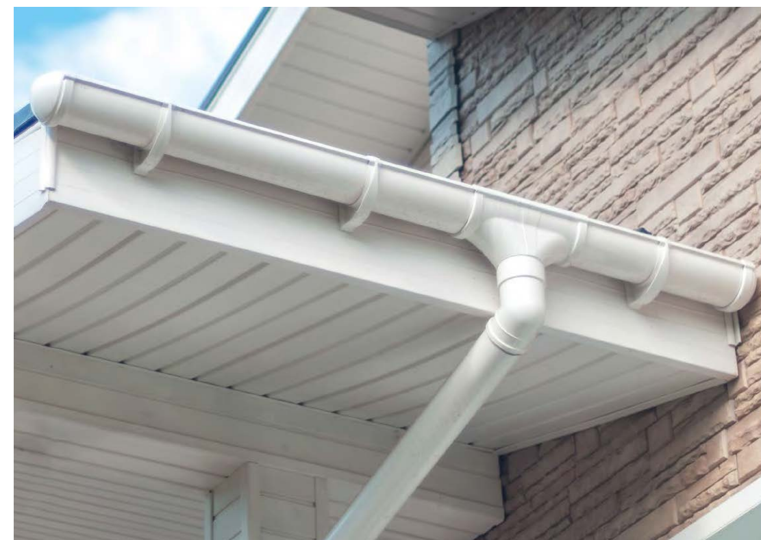
Пример монтажа водосточной системы LUX
