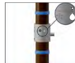
1. Водосборник установлен в летний режим (положение «капля»)
