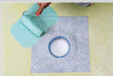
Герметизация сливного трапа пластырем LITOBAND P
