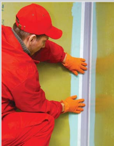
Герметизация стыка "стена-стена" лентой LITOBAND R
