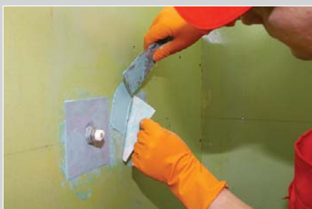
Герметизация выпуска трубы пластырем LITOBAND S
