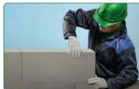
**ВНИМАНИЕ!** Не использовать для связывания блоков с отклонениями по размеру >1 мм и неправильной формой, а также для связывания строительных блоков с пустотами в соответствии с патентом ЕР 1 623 078 B1.
