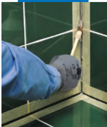
Нанесение Primer FD
