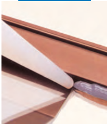
Герметизация алюминиевой оконной рамы Mapesil AC
