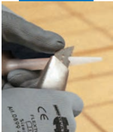
Отрезание носика в соответствии с размером швов
