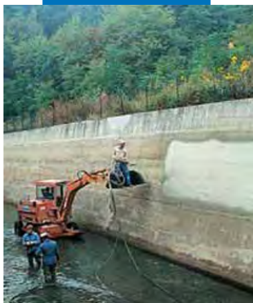
Нанесение Planiseal 88 напылением на подводный канал гидроэлектростанции
