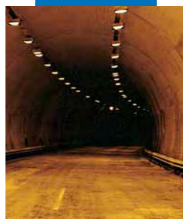
Нанесение белого Planiseal 88 напылением в автодорожной галерее
