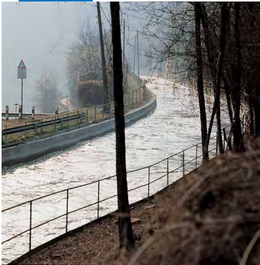
Подводящий канал ГЭС в г. Бертини – Робьяте (Область Комо) с поверхностью, обработанной Planiseal 88
