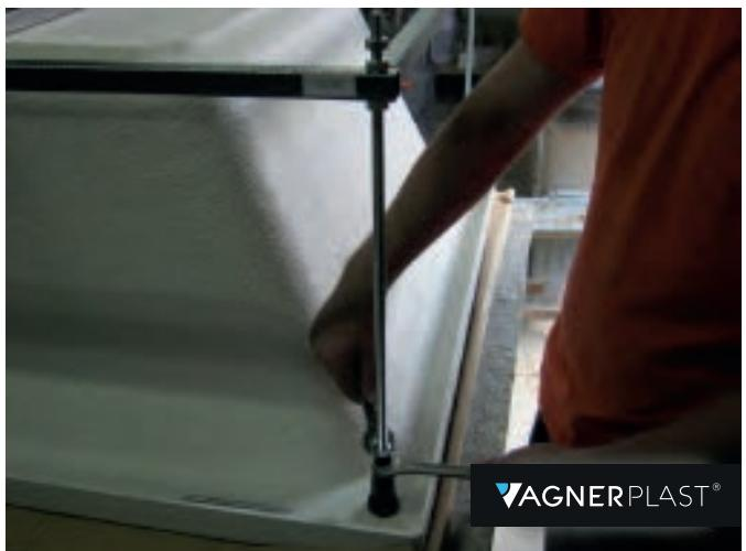
⑨ На шпильки накручиваются ножки
