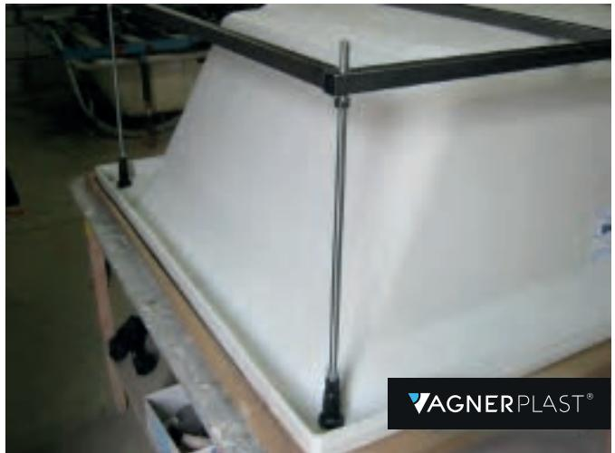
③ Каркас располагается на ванне симметрично относительно ее геометрического центра
