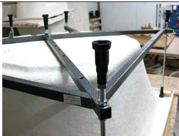
Каркас следует выровнять по ванне таким образом, чтобы пластиковые насадки в верхней части высоких резьбовых шпилек (при рабочем положении ванны) располагались на горизонтальной плоскости между внешним загибом бортика и стенкой ванны.
