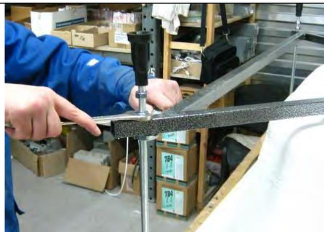
4. Выровняйте регулируемые пластиковые ножки и затяните фиксирующие гайки.
