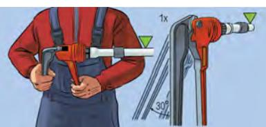
**Внимание!** Применение смазки, герметиков и т.п. при монтаже аксиальных фитингов не допускается.
