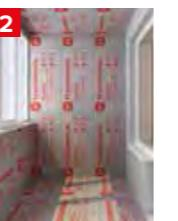
Перед приклейванием гладких плит экструзионного пенополистирола на стены необходимо равномерно отфрезеровать их с помощью ножовки или металлической щетки.
