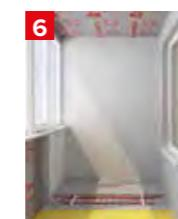
Перед укладкой нагревательных элементов на пол должна быть сделана сборная или армированная цементно-песчаная стяжка.
