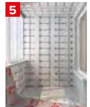
Перед монтажом финишного слоя (панелей МДФ, вагонки, пластиковых панелей) нужно организовать вентиляционный зазор, необходимый для прокладки коммуникаций (электрика, отопление, водоснабжение) без нарушения слоя пароизоляции с помощью контробрешетки из деревянных брусьев. Толщина зазора не менее 30-40 мм.
