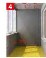
После дюбелирования производится нанесение базового штукатурного слоя с армированием щелечесткой сеткой. Толщина нанесенного штукатурного слоя на плиты не менее 6 мм.
