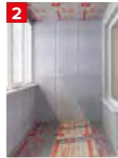
Для теплоизоляции стен балкона с отделкой декоративной штукатуркой рекомендуется применять специализированный материал XPS ТЕХНОПЛЕКС с фрезерованной поверхностью. Если вы используете гладкие плиты экструзионного пенополистирола, то они должны быть равномерно отфрезерованы с помощью ножовки или металлической щетки.
