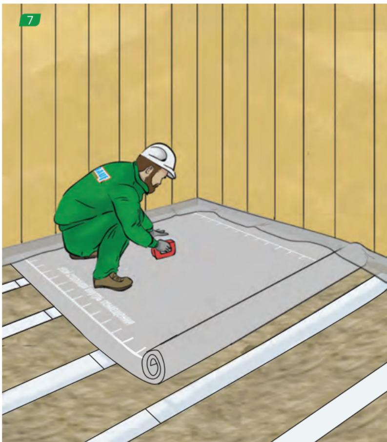
Поверх утеплителя поперек балок раскатываем пароизоляционную пленку и фиксируем ее по балкам степлером. Каждый последующий слой – с нахлестом 10-15 см.
