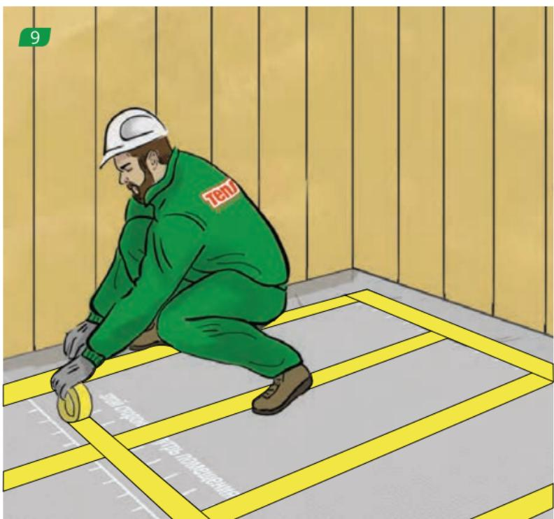
Стыки и места крепления пленки проклеиваем лентой для проклейки швов. Пароизоляция, уложенная на стене, должна быть проклеена с пароизоляцией, раскатанной на полу, для создания герметичного контура.
