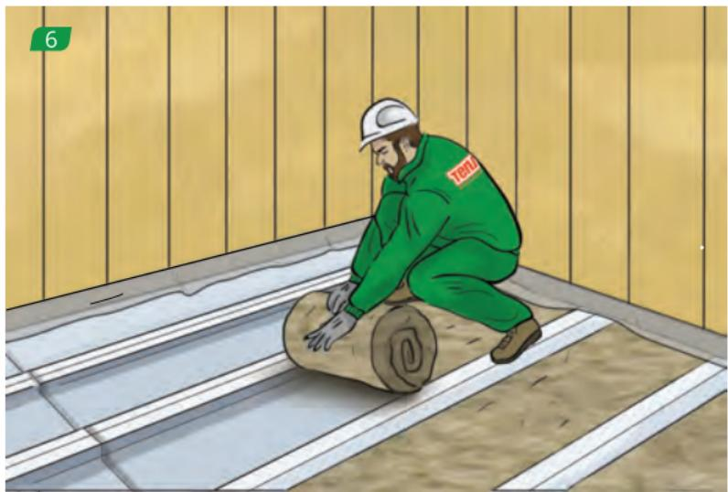
Укладываем утеплитель между балками.
