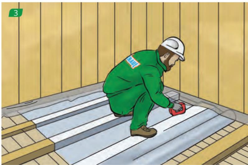
Раскатываем ветро-гидрозащитную мембрану
