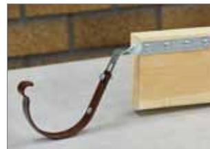
**1.3.** Боковой удлинитель закрепите на готовую кровлю к боковой поверхности стропильной ноги.
