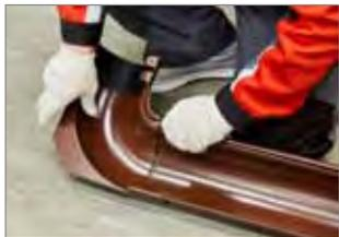
**5.** На углах желоба соедините при помощи угловых элементов. Соединение также производите изнутри наружу. На кронштейне загните фиксатор.
