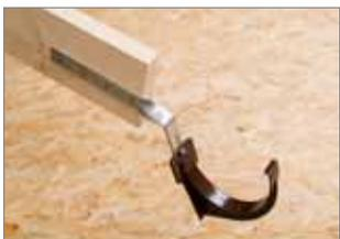
**3)** К стропильным ногам через удлинитель кронштейна боковой (применяется, когда монтаж кровли уже закончен).
