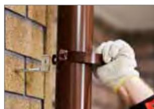
**7.** Трубы к стене крепятся при помощи хомутов. Предварительно подготовьте под них крепеж в соответствии с отступом от фасада и толщиной теплоизоляции. Крепеж должен заходить минимум на 50 мм в несущую конструкцию. Хомуты крепятся с шагом не реже, чем 1,5 м друг от друга. Хомут должен обязательно фиксировать колено, которое прижимает трубу к фасаду.
