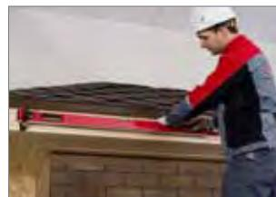
2. Определите места установки водосливных воронок. Воронка может располагаться с краю или по центру. Установите кронштейн на противоположной стороне карниза, соблюдая наклон. Одна воронка для системы 125/82 рассчитана на 50 кв. м, для системы МАКСИ — на 100 кв. м, но не менее одной воронки на скат.
