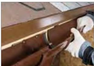
**4.** Вставьте желоба внутрь воронки до обозначенной линии. Соединение желоба с воронкой необходимо производить в направлении «изнутри наружу»: от внутренней стороны желоба (от фасада здания) к внешней до защелкивания с фиксирующим элементом воронки.
