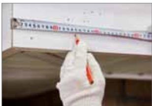
**1.** Определите место крайних кронштейнов на карнизе. Они должны находиться на расстоянии не более 15 см от края крыши. Определите место, где будет воронка. Отметьте это место.
