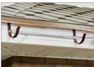
**1.1.** Зафиксируйте первый кронштейн. Кронштейн, ближайший к воронке, зафиксируйте с учетом уклона и протяните шнур между этими кронштейнами. По шнуру выставите остальные кронштейны с шагом 60–70 см.
