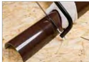
**7.** В случае расположения воронки на краю карниза, чтобы закрыть воронку заглушкой, вам необходимо соединить воронку и заглушку отрезком из водосточного желоба. Распил желоба производите ножовкой с мелкими зубьями с последующей зачисткой среза напильником.
