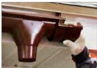
**4.** Желоб с воронкой присоедините к другому отрезку желоба через соединитель. Наденьте на соединитель кронштейн, зажмите фиксатор и прикрепите кронштейн к лобовой доске.
