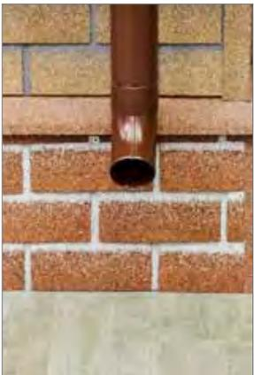
**8.1.** Минимальное расстояние слива от земли — 20 см, при наличии отмостки — 15 см от уровня отмостки. Слишком низкое расположение водосточного слива к земле повышает риск образования наледи внутри трубы, что может ухудшить работоспособность всей системы и привести к разрыву трубы.
