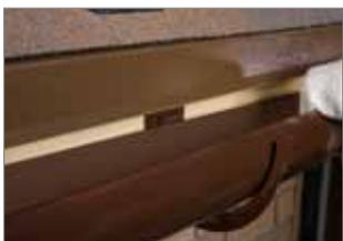
**5.** Установите водосточные желоба в кронштейны до защелкивания с фиксирующими элементами кронштейна. Соединение желоба с кронштейном также необходимо производить в направлении «изнутри наружу».
