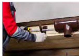
3. Натяните веревку с необходимым уклоном между крайним кронштейном и воронкой. Ближайшие к воронке кронштейны устанавливайте с каждой стороны элемента на расстоянии 100–150 мм.
