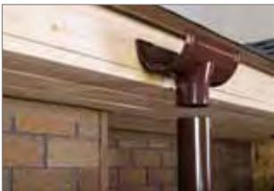
**11.1.** В случае отсутствия карнизного вылета соедините водосточную воронку с трубой.
