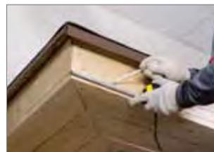
1. Определите места крайних кронштейнов на карнизе. Отметьте эти места. Кронштейн желоба должен находиться от края карниза на расстоянии не более 150 мм.
