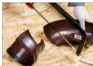
**9.1.** Если угол поворота кровли не равен 90°, используйте угол желоба регулируемый, который состоит из двух элементов и подрезается по месту по отметкам угла поворота, заранее нанесенным на заводе-изготовителе. Соединение дополнительно герметизируйте.
