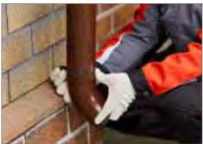
**8.** Заканчиваем монтаж системы установкой слива. Фиксируем его хомутом.
