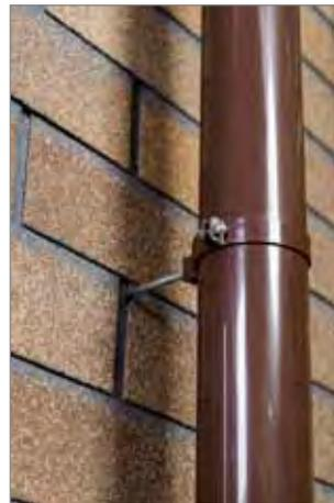
**а)** Установите дюбель в несущую часть фасада. Механический крепеж хомута подбирается в соответствии с отступом от фасада и толщиной теплоизоляции и должен заходить минимум на 50 мм в несущую конструкцию.
