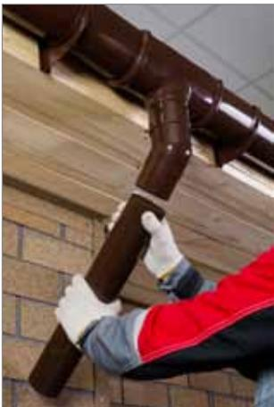
**11.** В случае наличия карнизного вылета для соединения воронки с водосточной трубой используйте два универсальных колена и отрезок трубы, подрезанный на требуемую длину. На нижнее колено обязательно установите хомут.
