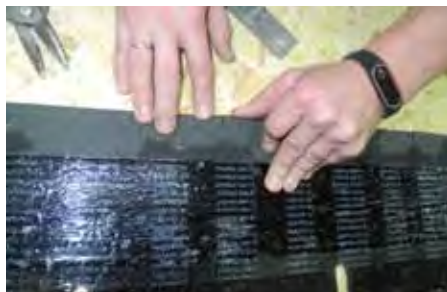
Рис. 6. Насечка для облегчения монтажа
