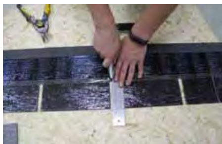
Рис. 7. Деление плитки на лепестки
