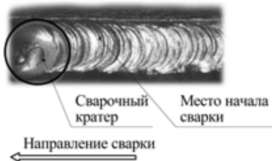
Рис. 7.5. Начало сварки при смене электрода.
