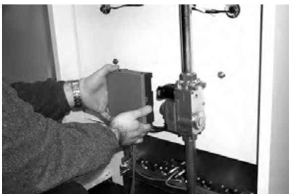
рис. 8 - Снимите блок управления
