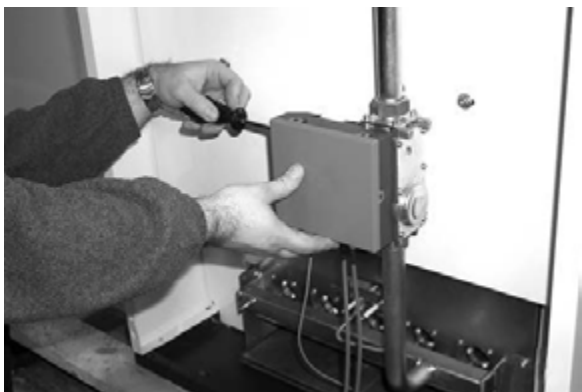
рис. 7 - Открутите два винта крепления блока управления
