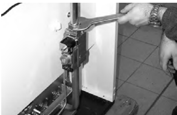
рис. 9 - Открутите гайку крепления газового клапана
