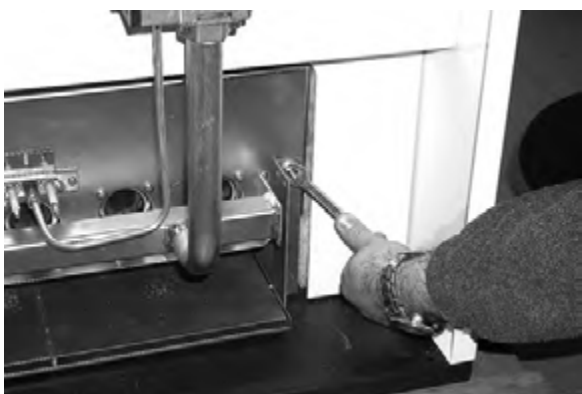
рис. 10 - Развинтите гайки крепления камеры сгорания
